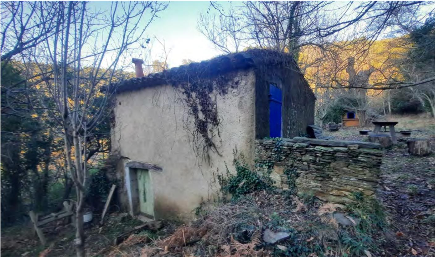
Bastidon de plan carré monté au mortier de chaux ; toiture à 2 pans. 1 porte et 1 fenêtre par niveau. Surface au sol de 23 m<sup>2</sup> hors œuvre, soit 46 m<sup>2</sup>. La porte du soubassement a été réduite.
