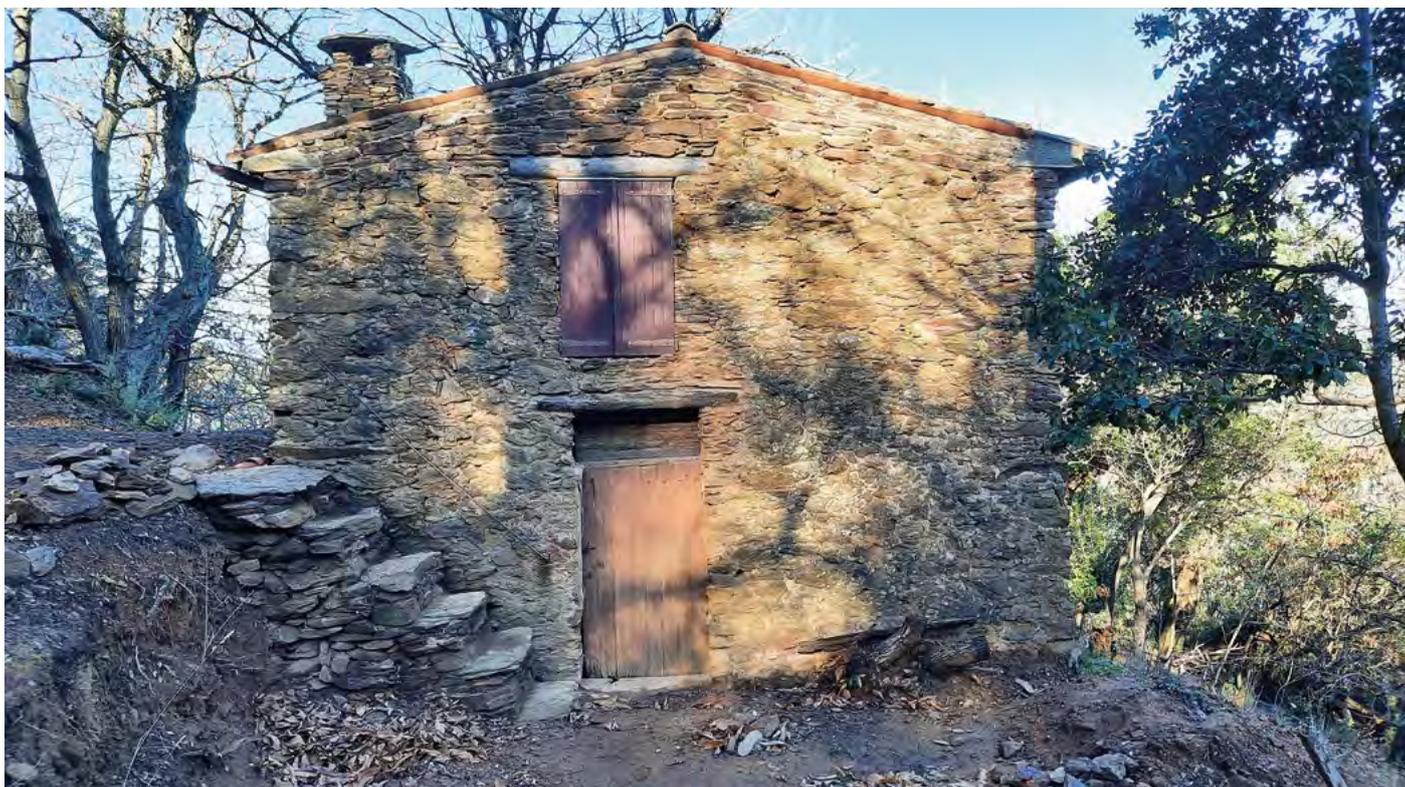
Bastidon de plan pseudo-carré monté au mortier de chaux ; toiture à 2 pans (légèrement exhaussé lors de sa restauration). 1 porte et 1 fenêtre par niveau. Surface au sol de 27 m<sup>2</sup> hors œuvre, soit 54 m<sup>2</sup>.
