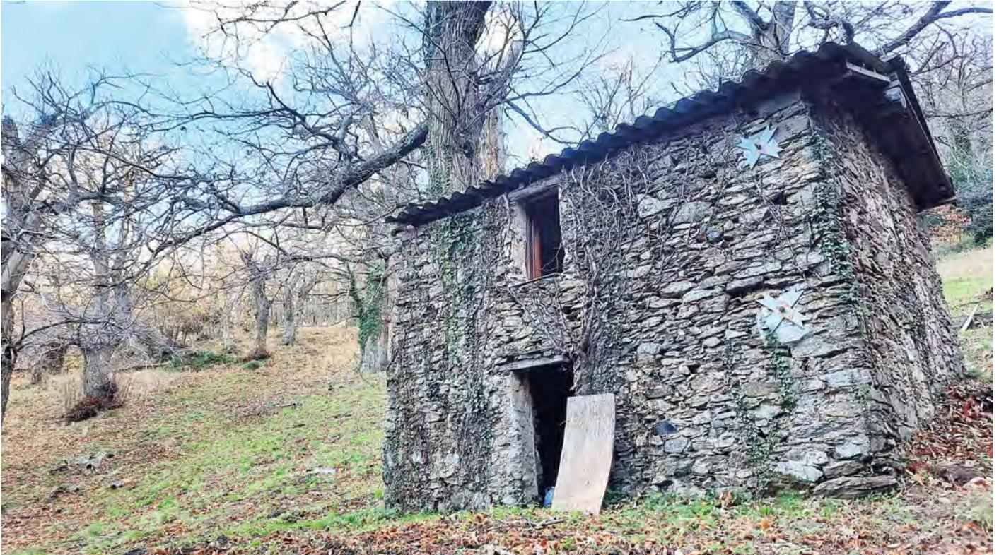
Bastidon de plan rectangulaire monté au mortier de chaux ; toiture à 2 pans. 1 porte et 1 fenêtre par niveau. Surface au sol de 21,8 m<sup>2</sup> hors œuvre, soit 43,6 m<sup>2</sup>. L'ouvrage a été en partie restauré (toiture, plancher). On peut observer les tirants sur le côté droit du bâtiment.
