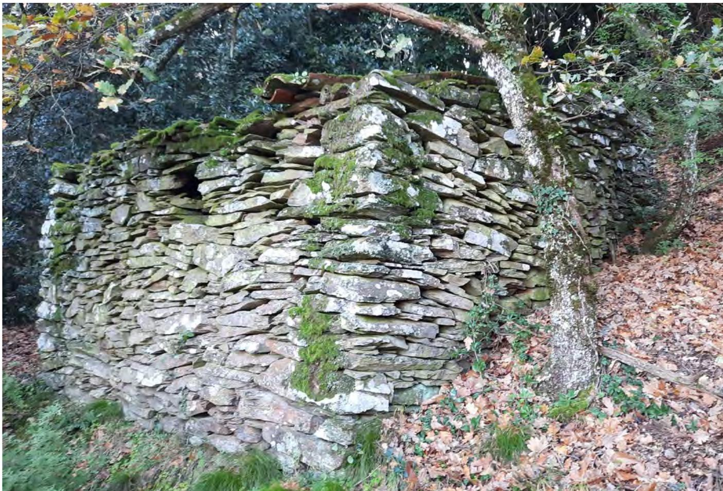
Petit cabanon en pierre sèche de 18 m<sup>2</sup>, de plan carré et toiture à 1 pan. Il est situé à quelques dizaines de mètres de la piste de Cros de Mouton. Ci-dessus, on aperçoit le *fenestroun* (petite fenêtre).
