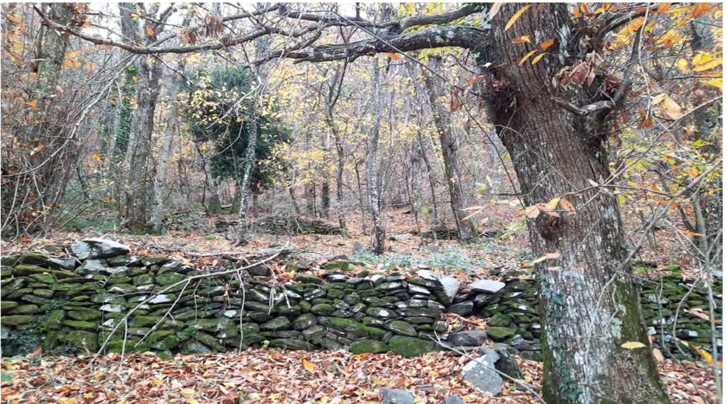
**Restanques de Rouve Gavot (IA8300018, Collobrières).** 2 restanques d'environ 43 m et 53 m de long x 1 m de hauteur quand le mur est bien conservé. Ces 2 murs forment 2 espaces d'environ 14 m de profondeur ; exposition SE. A souligner, le montage du mur « en délit » par endroit (c'est-à-dire que les pierres sont dressées verticalement, ne suivant pas les strates de la pierre ; cette pose rend le mur plus fragile, mais est parfois employée pour améliorer le drainage de l'eau de ruissellement).
