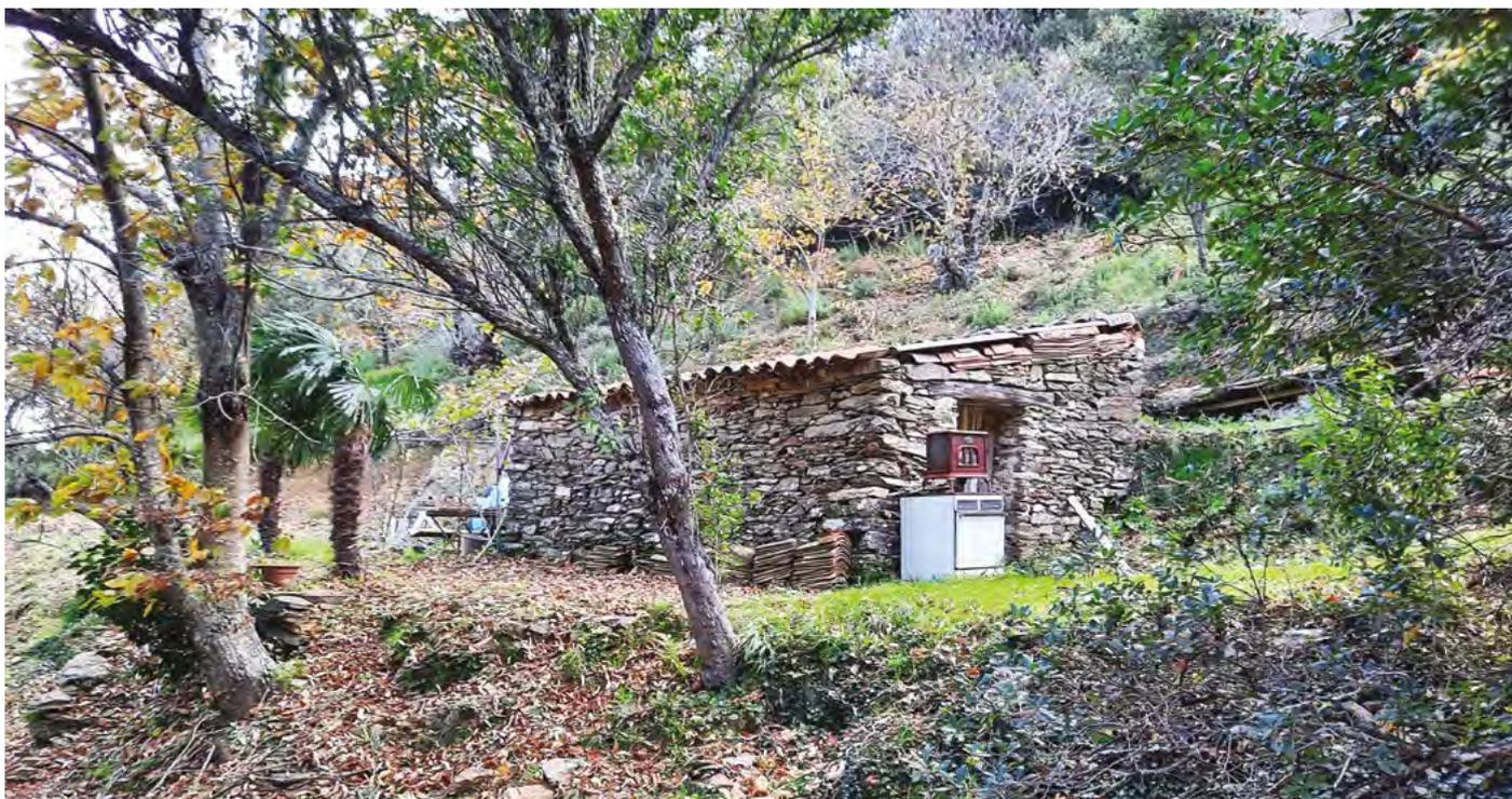
Cabanon de plan rectangulaire, monté au mortier de chaux, d'une surface de 15 m<sup>2</sup>, toiture à 1 pan. L'ouvrage a été restauré.
