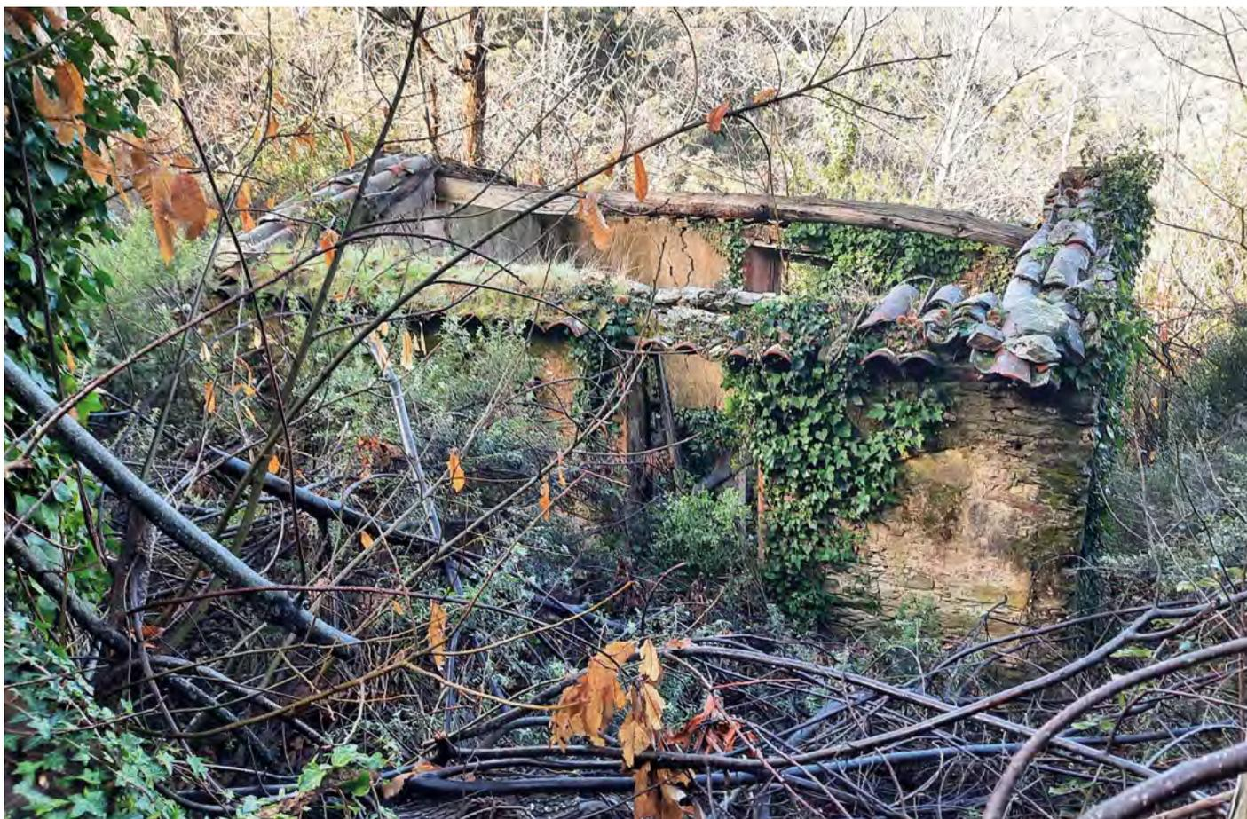
Bastidon de plan rectangulaire monté au mortier de chaux ; toiture à 2 pans. 1 porte et 1 fenêtre par niveau. Surface au sol de 25 m<sup>2</sup> hors œuvre, soit 50 m<sup>2</sup>. La ruine est située sur un circuit de randonnée qui rejoint le GR 90.
