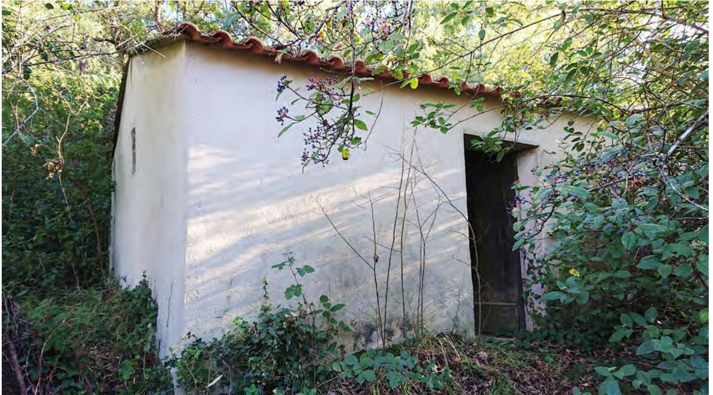
Cabanon de plan rectangulaire, entièrement restauré. Il est monté au mortier de chaux ; toiture à 2 pans. Surface totale de 29,6 m<sup>2</sup>. L'ouvrage comporte 2 pièces distribuées dans la longueur et d'inégales surfaces.
