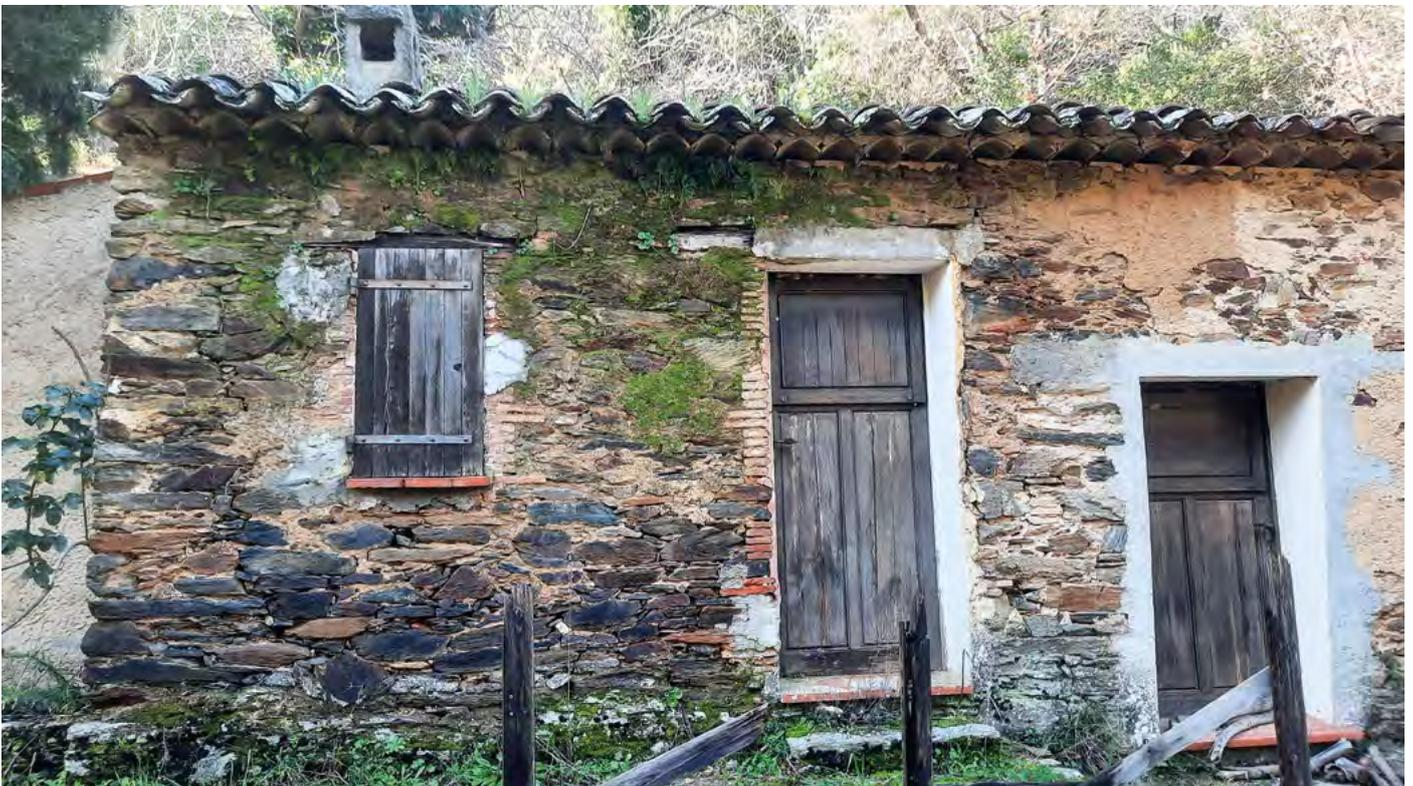
Détail de la façade avec les linteaux en bois qui apparaissent derrière le ciment dégradé. On peut observer, à gauche, les modifications opérées sur la fenêtre et la porte, toutes deux réduites, dont les piédroits ont été repris avec des briques. La porte à droite a été restaurée ; impossible de dire s'il s'agit d'une création nouvelle ou d'une restauration.
