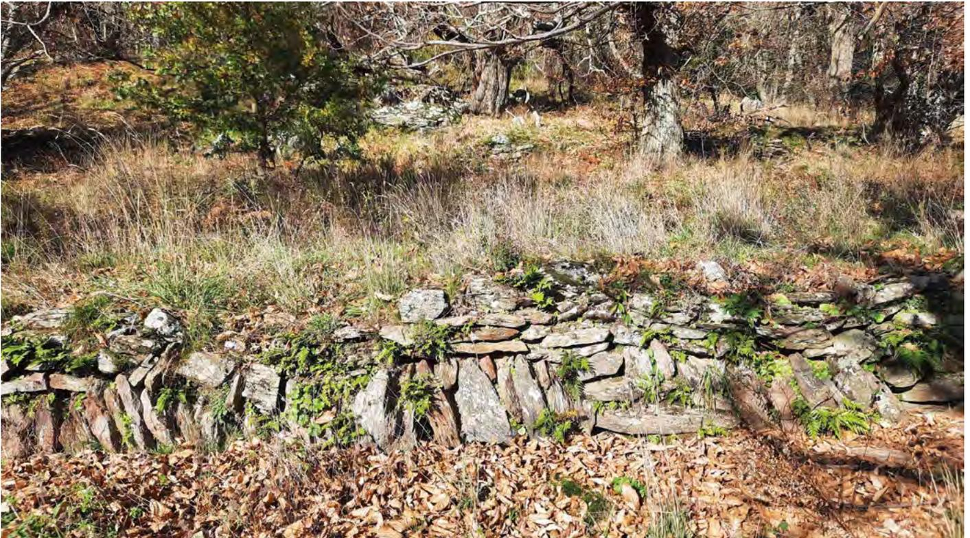
**Restanques de Cancivaou 2 (IA8300027, Les Mayons).** De nombreuses restanques se succèdent, entre 10 et 60 m de longueur et des hauteurs entre 0,80 et 1,20 m. Ces restanques offrent des terrasses de superficies assez grandes, avec des intervalles compris entre 15 et 25 m ; exposition NE.
