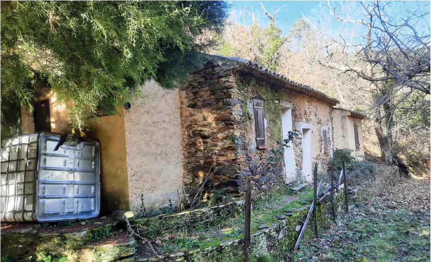
Cabanon de plan rectangulaire, restauré et agrandi de chaque côté de l'ancien bâti. Il est monté au mortier de chaux ; toiture à 2 pans. Surface totale de 38 m<sup>2</sup>. L'ouvrage ne devait compter que 2 pièces, mais l'ouverture plus récente de nouvelles baies rend difficile la lecture de l'édifice dans son état initial.
