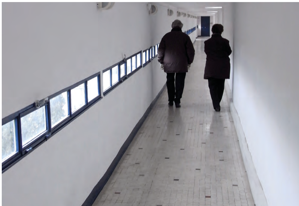
Photo 9. Les fenêtres du couloir permettent un éclairage naturel mais limitent la vue sur l'extérieur (photo E. Vieux).
